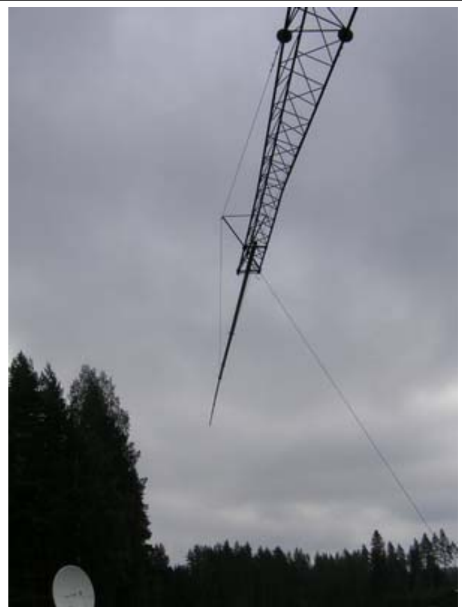
160:n elementti ja sen kavennus/jatko alumiiniputkella.
